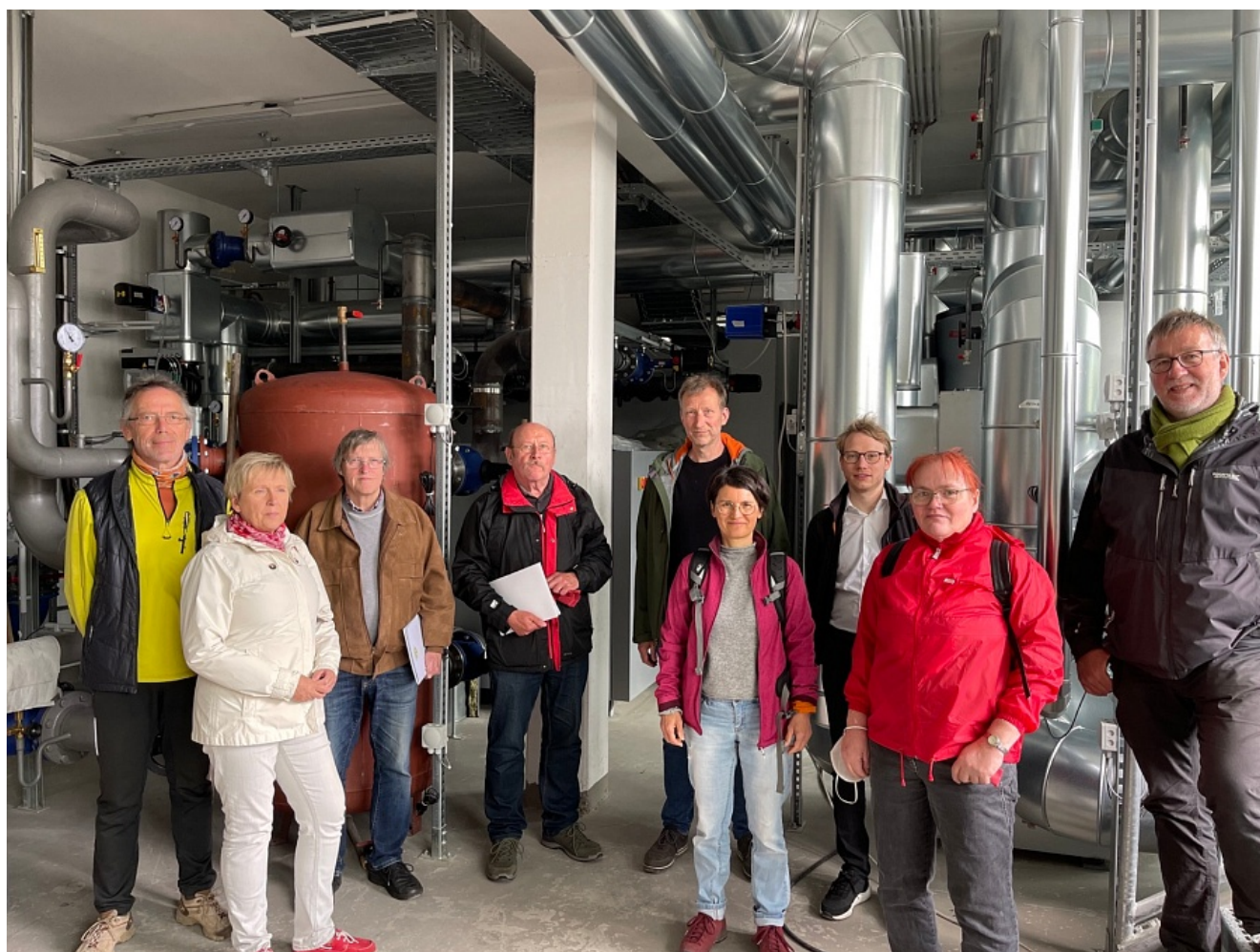
In der Energiezentrale, Ökosiedlung Friedrichsdorf: Von links:
